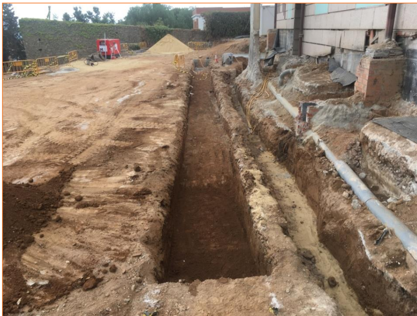
Foto 16. Vista de la rasa del muret guia i del nou servei de gas.
