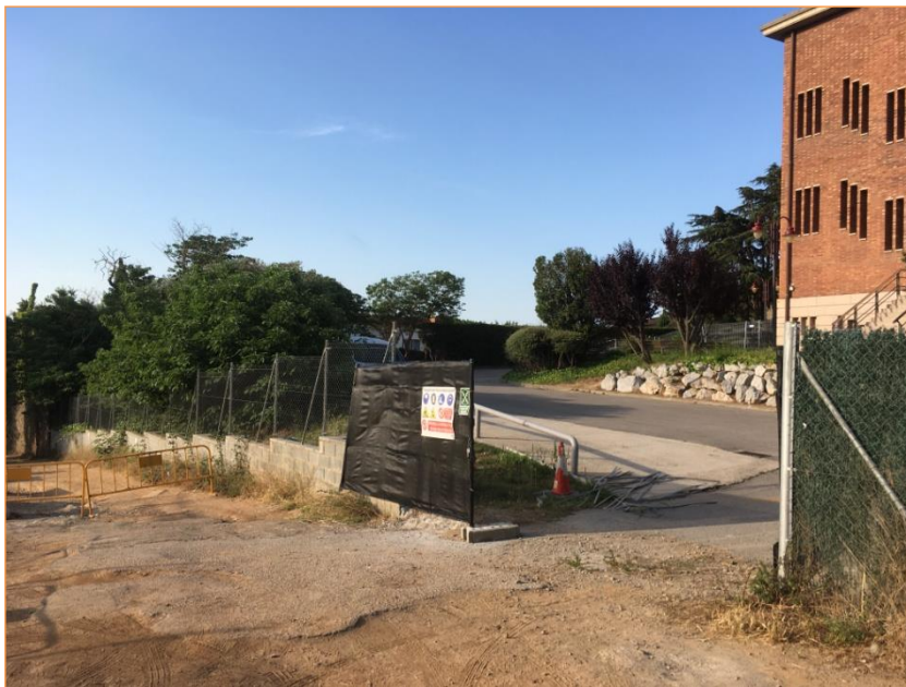
Foto 2. Vista d'estat inicial de la zona abans de l'inici de les obres.
