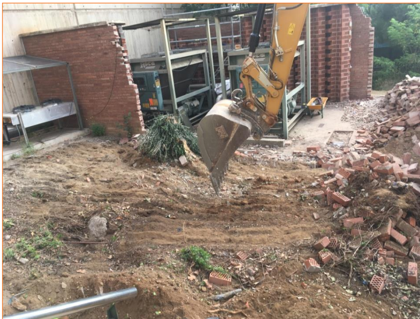
Foto 20. Vista dels treballs d'excavació a la banda nord.
