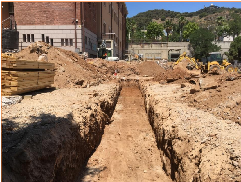
Foto 12. Vista del primer tram del muret guia a la banda oest.
