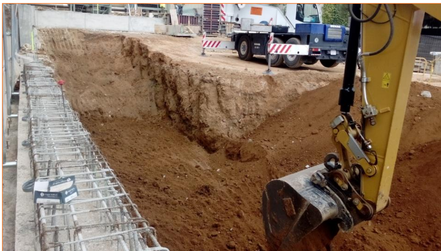
Foto 24. Vista de l'inici dels rebaixos generals
