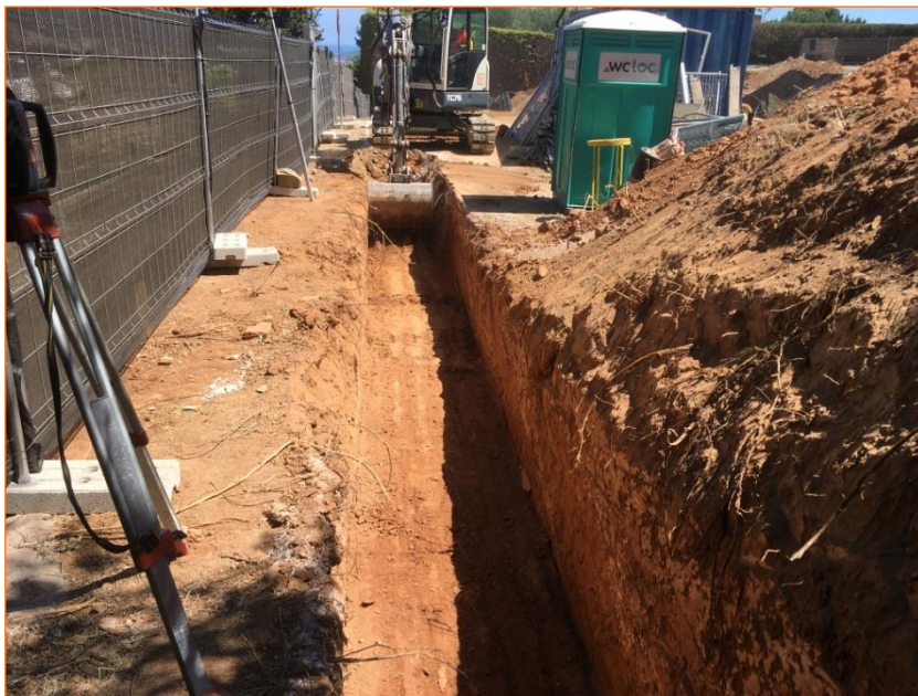
Foto 14. Vista del primer tram del muret guia a la banda est.
