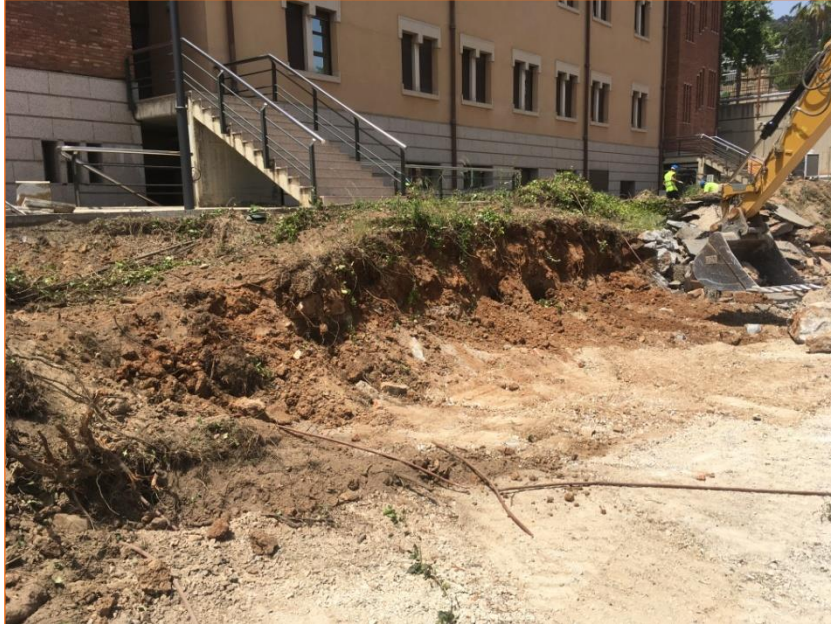
Foto 5. Vista dels treballs d'excavació del nivell superficial (UE 1).
