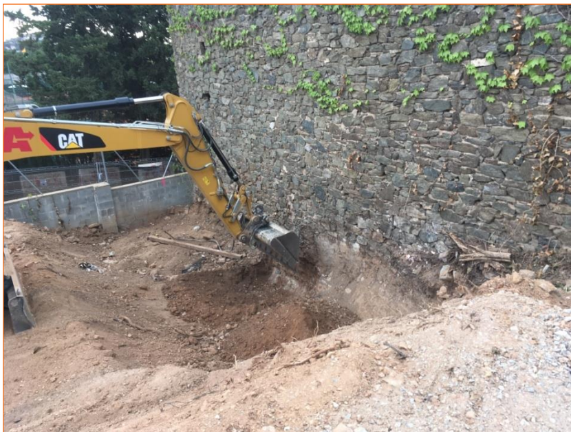
Foto 18. Vista inicial del sondeig al costat del mur UE 7.
