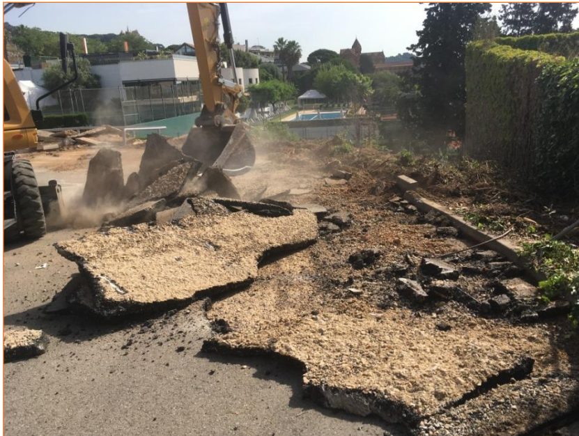
Foto 22. Vista de la capa d'asfalt UE 2.
