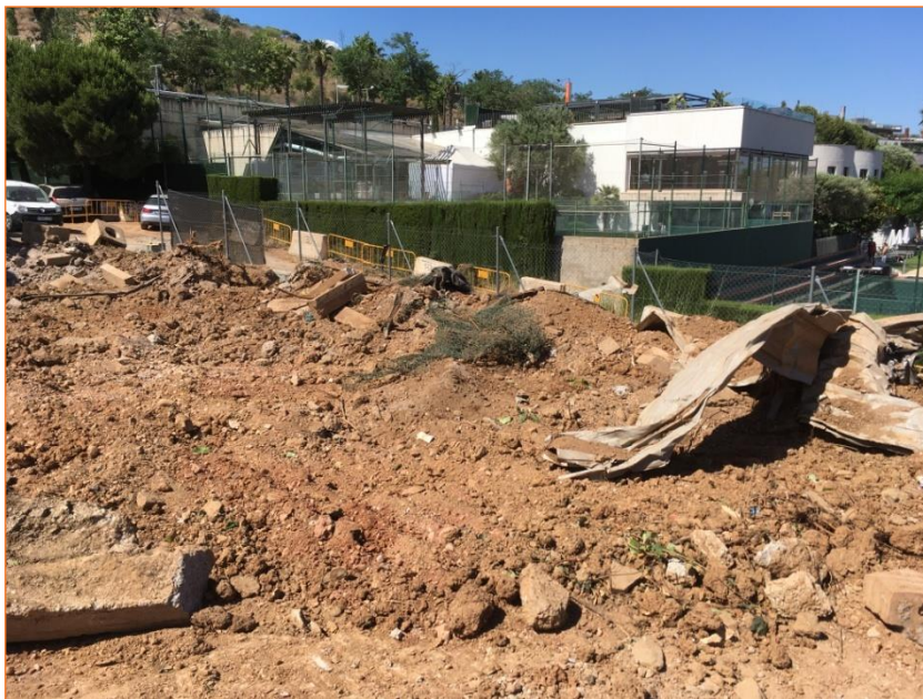
Foto 6. Vista dels treballs d'excavació del nivell superficial (UE 1).
