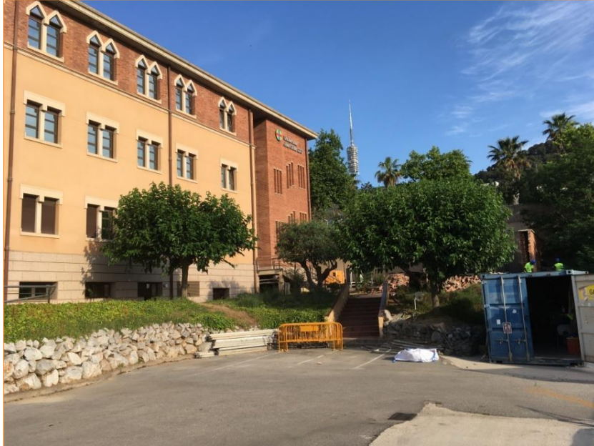
Foto 1. Vista d'estat inicial de la zona abans de l'inici de les obres.
