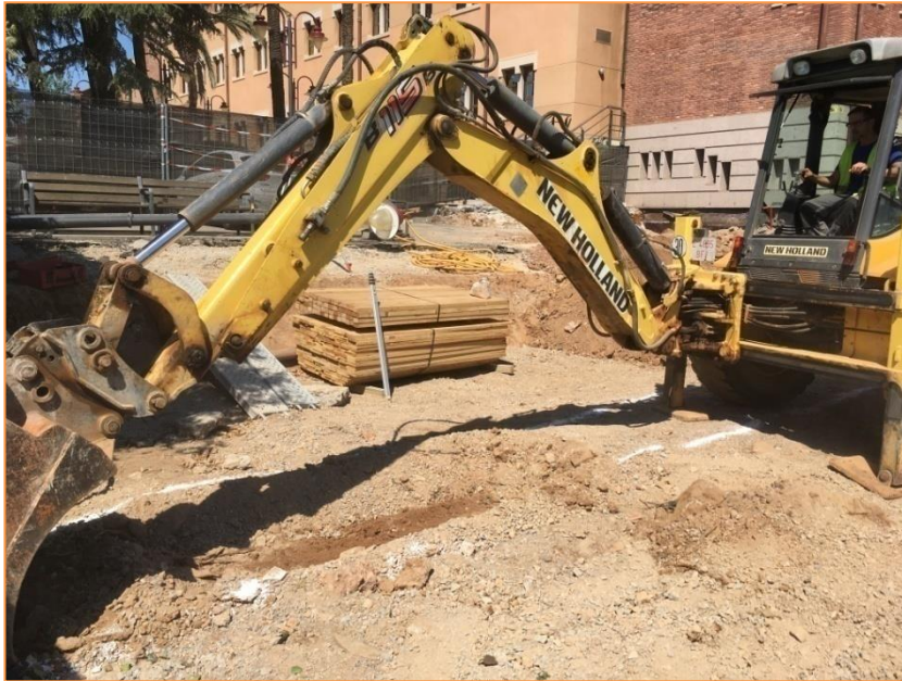
Foto 11. Vista de l'inici d'excavació del muret guia a la banda oest.
