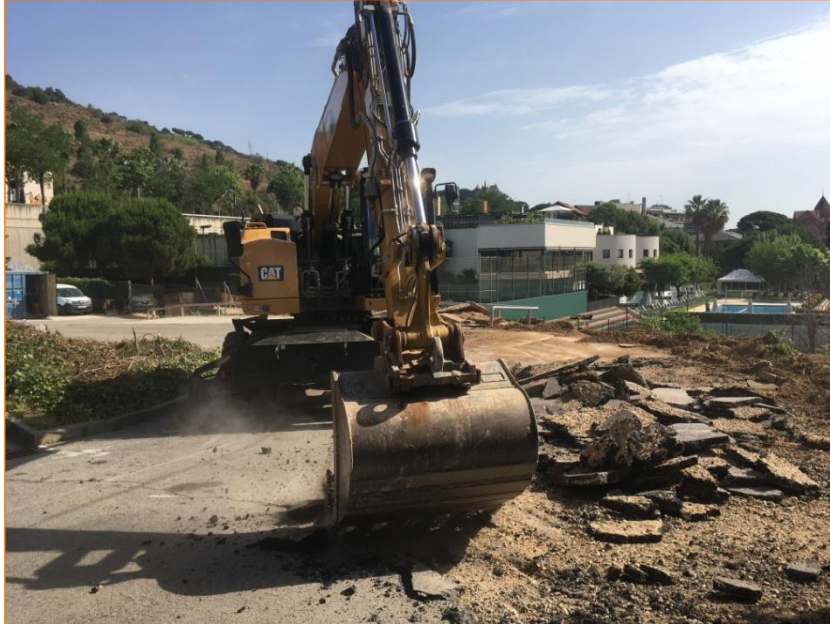
Foto 7. Vista dels treballs d'excavació de la capa d'asfalt i ciment (UE 2).
