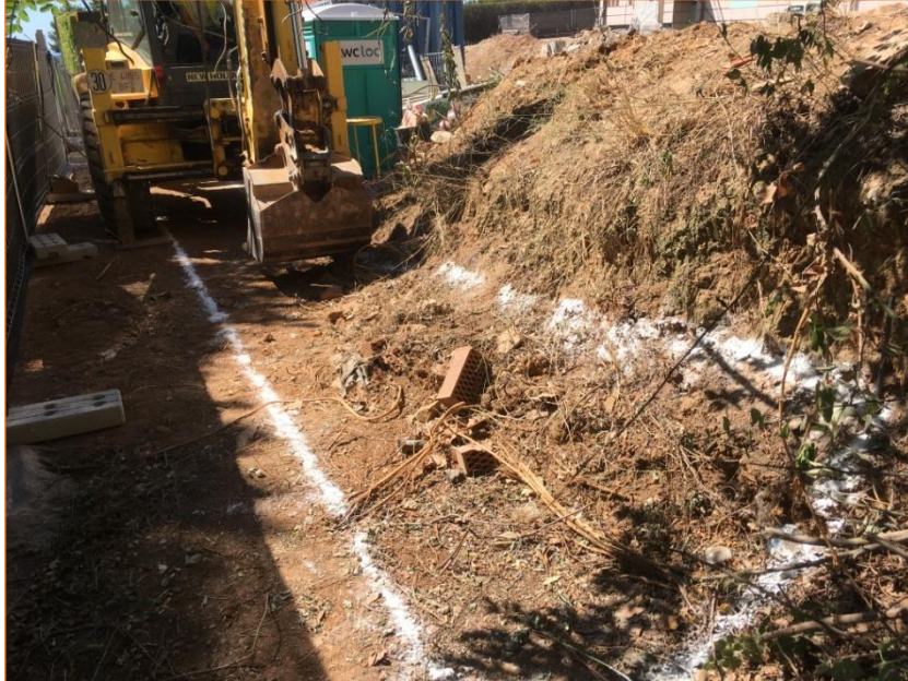
Foto 13. Vista de l'inici d'excavació del muret guia a la banda est.
