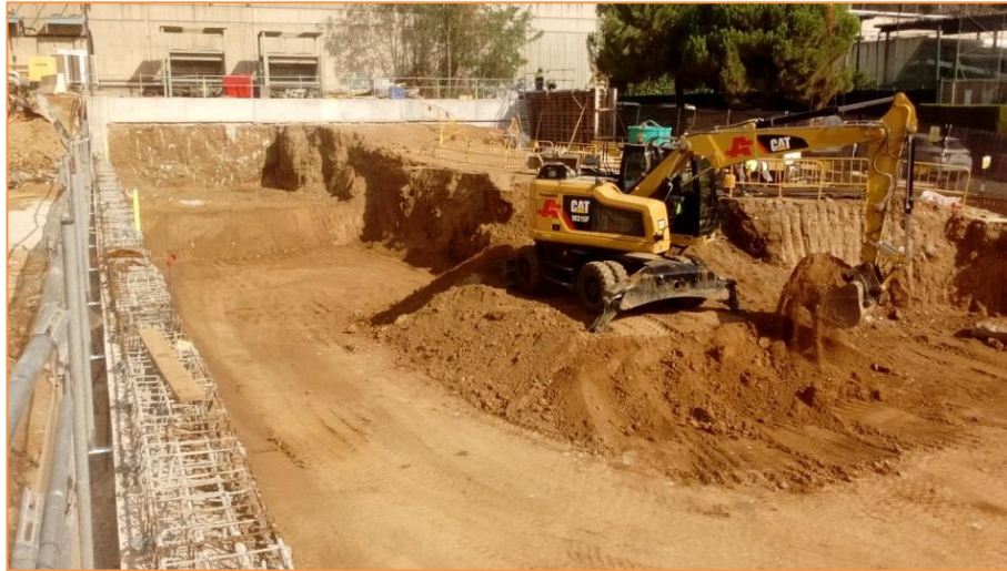
Foto 25. Vista del procés d'excavació dels rebaixos generals.
