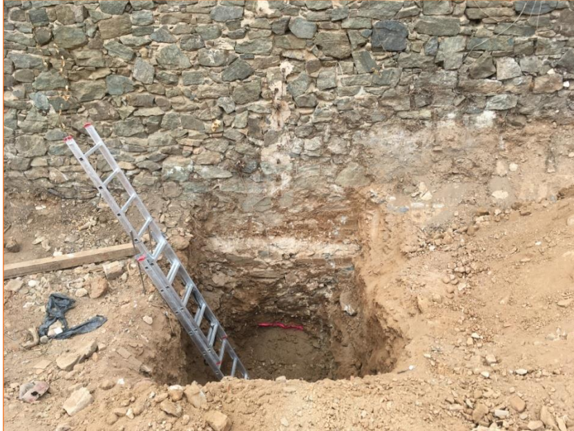
Foto 19. Vista final del sondeig per veure la fonamentació del mur UE 7.
