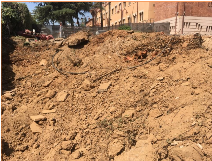
Foto 10. Vista del nivell UE 1 a la banda sud-est
