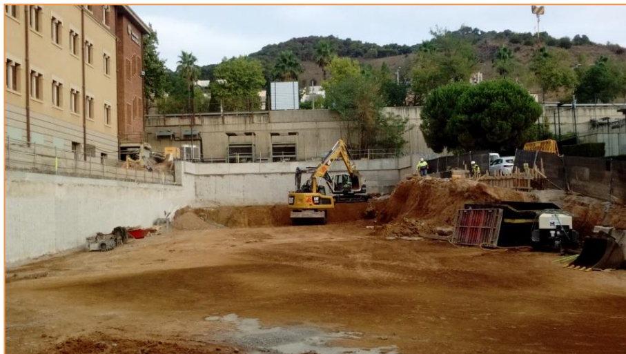
Foto 26. Vista final del solar un cop fet els rebaixos generals.
